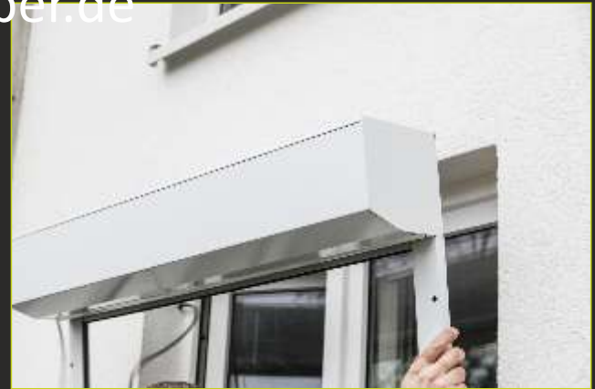
Vorbaurolläden fachgerecht und sauber montiert
